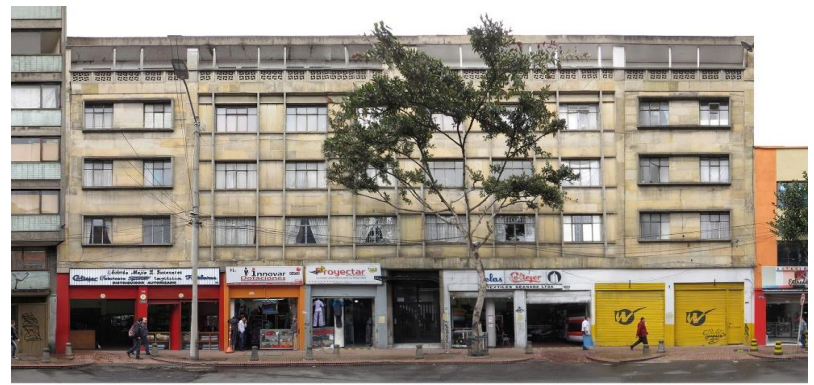
Fuente: Equipo Fotografía PEMP Patrimonio Inmueble
